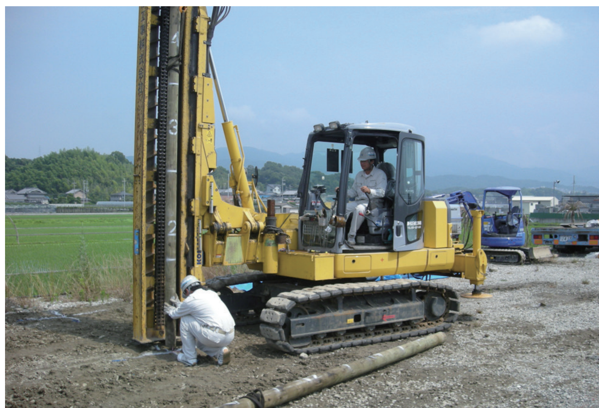
「環境パイル工法」の様子
