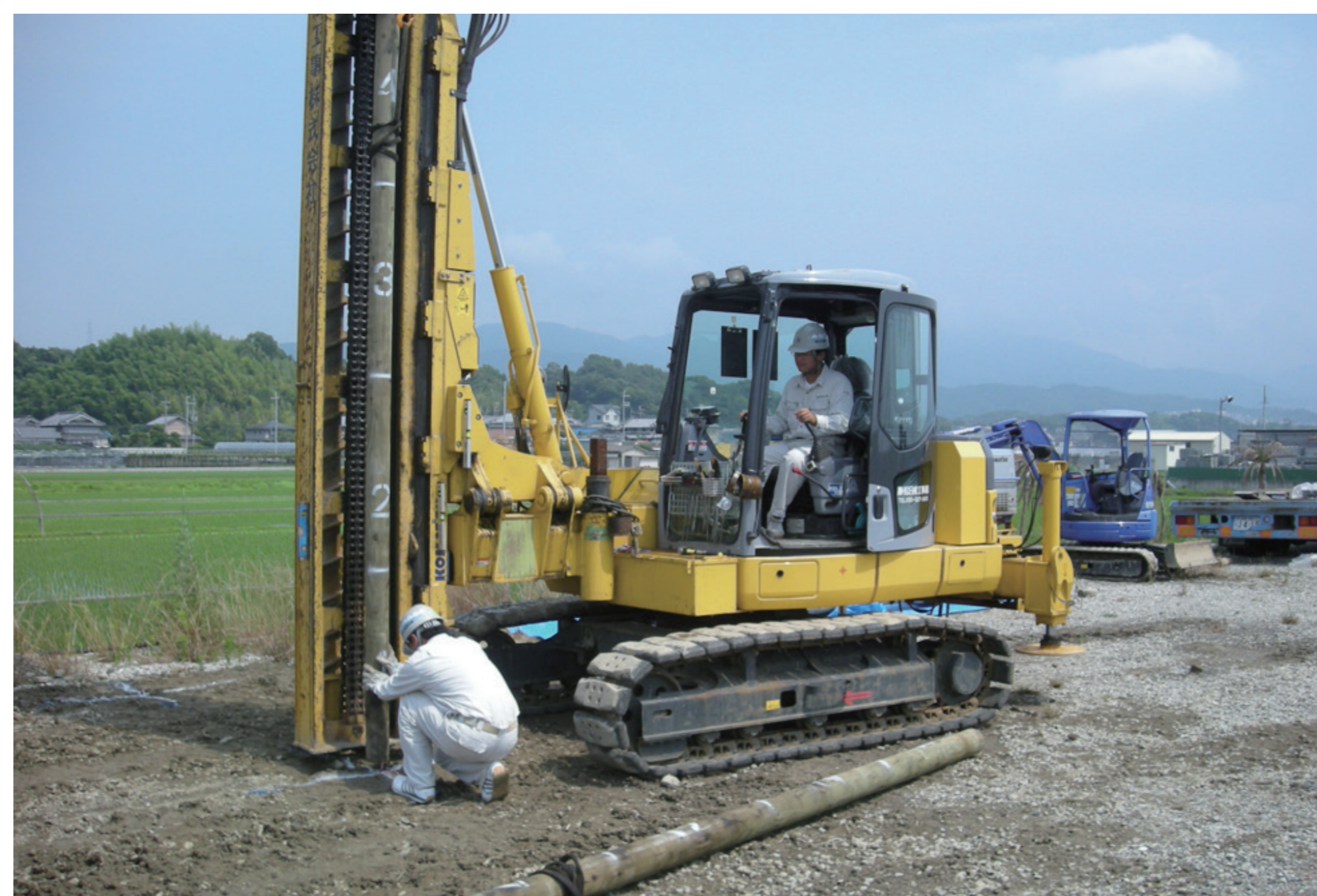
「環境パイル工法」の様子
